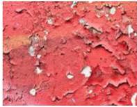
Liste B : Matériaux accessibles sans travaux destructifs
