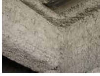
Liste A : Flocages, calorifugeages, faux-plafonds
